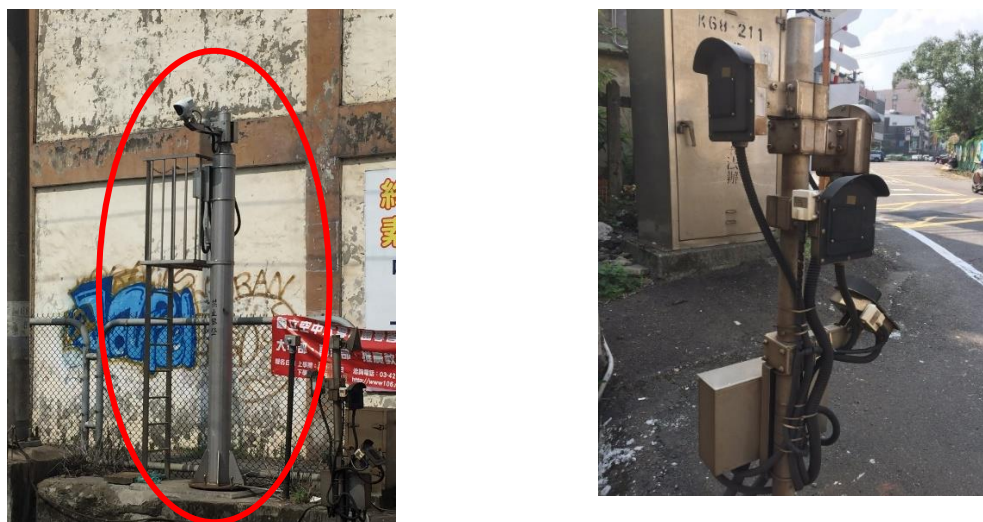
圖 53 平交道障礙物偵測系統 左：紅外線攝影機，右：毫米波雷達 (圖片來源：研究者自行拍攝)
