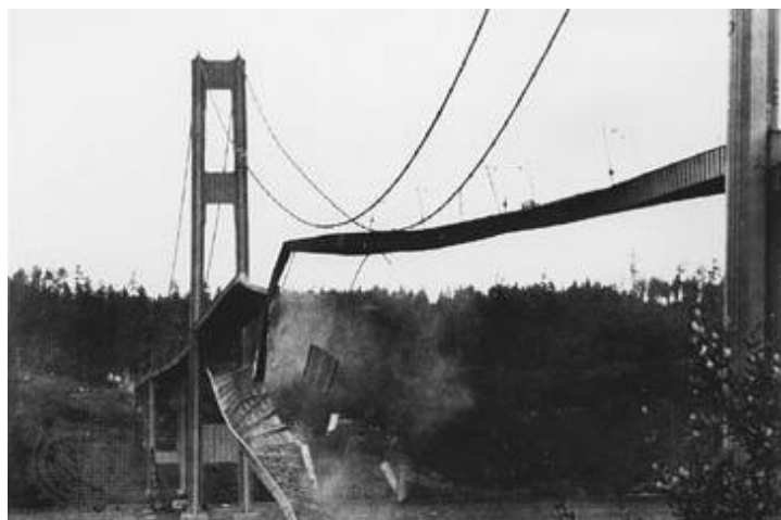
圖 3.1 1940 年美國塔科馬海峽吊橋(Tacoma Narrows Bridge)風毀事件
