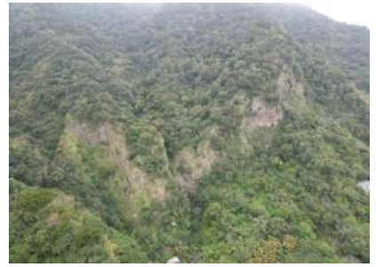
圖 16 相連之火山碎屑崩壁
