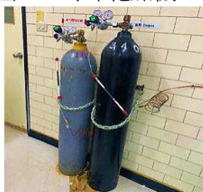
圖七、元素分析儀連接之氣瓶(灰瓶：氮氣，黑瓶：氧氣)
