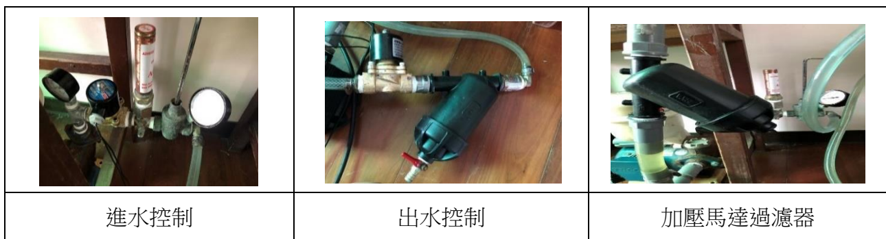
【圖 12】調壓流量控制閥安裝情形
