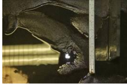
圖 4-10 20 公分壩堤堤前堆積測量
