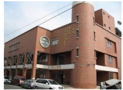
圖 5-1 二水「螺溪石藝館」
