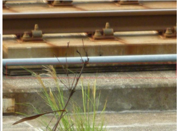
圖五十六、鐵軌下方墊片
