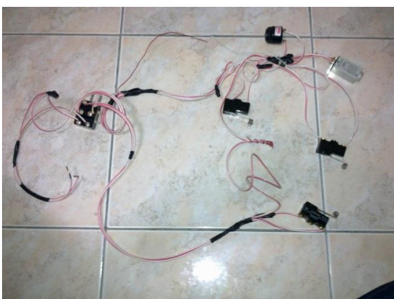
初步線路安裝製作
