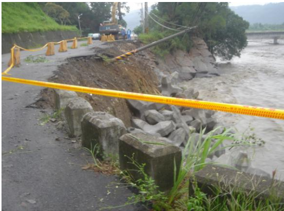
圖 5 芭瑪風災後之災情 (路基被洪水沖刷，2009 年 10 月 06 日)
