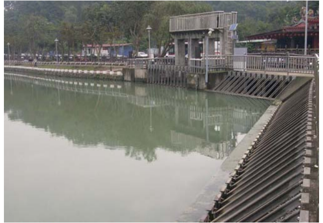
彩圖 36、排砂閘門可進行調節性排水
