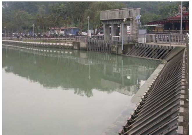
彩圖 30、排砂閘門可進行調節性排水
