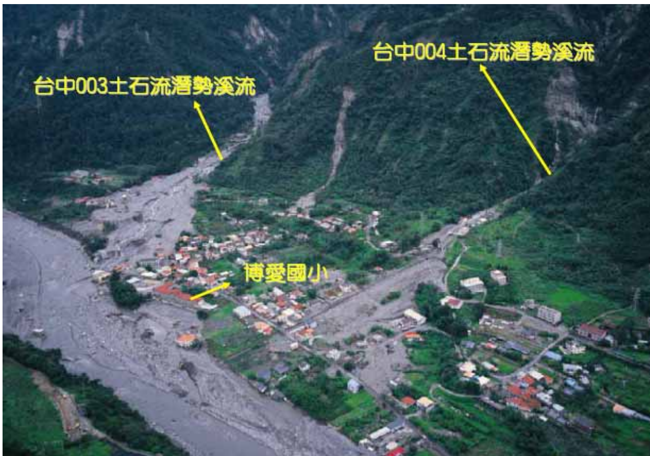
圖六 七二水災後松鶴土石流災區航照圖【1】
