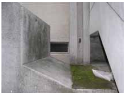
中原大學中正樓北側樓梯下方 (照片 3-1)
