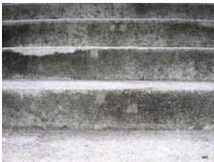
(照片 2) 中原大學中正樓北側樓梯
