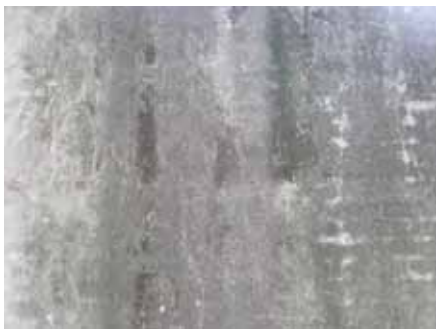
武陵高中警衛室的牆 (照片八)
