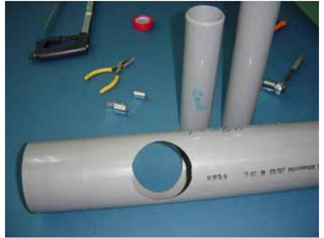
照片 12 水平導光管中央相接合孔完成圖
