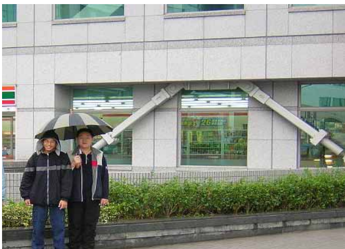
參觀台新銀行大樓斜撐鋼樑 加裝油壓避震系統
