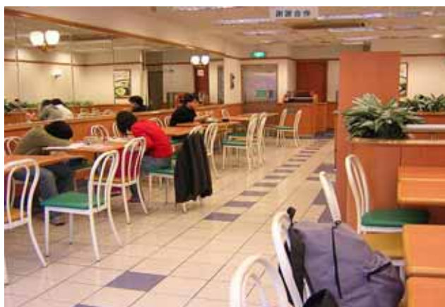
打通室內牆，改變隔間
