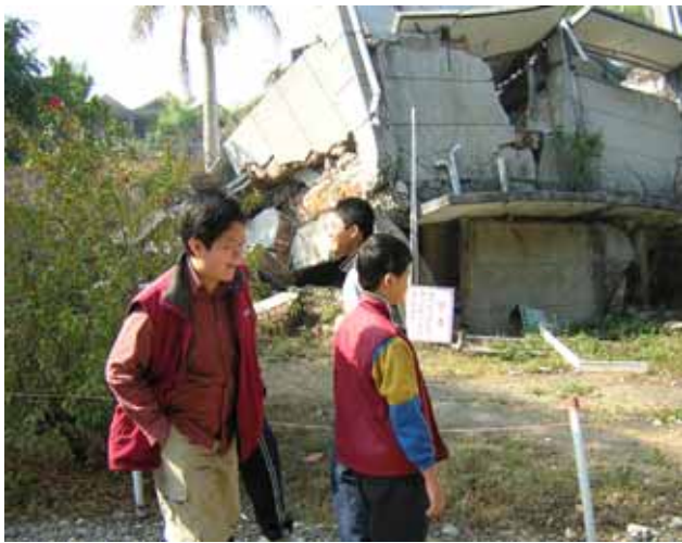
921 地震倒塌的建築物
