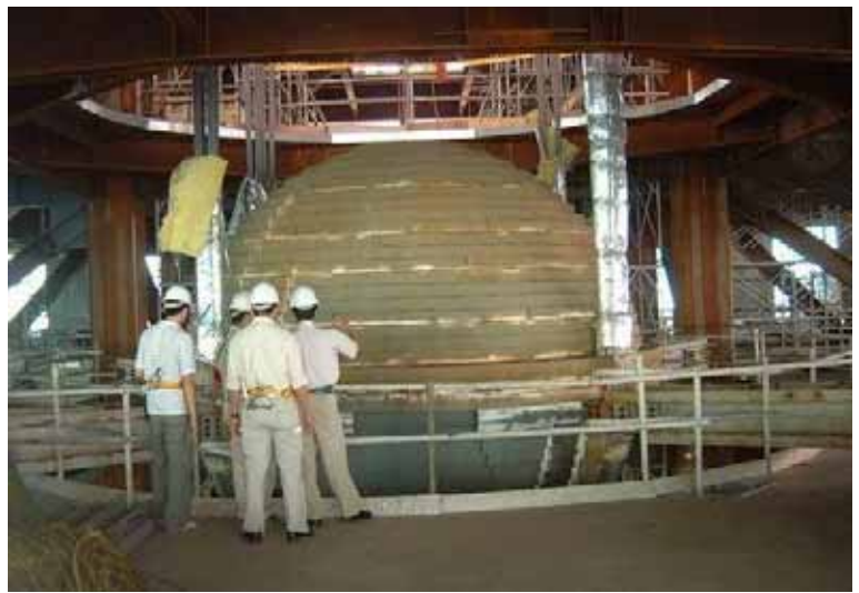
101 大樓內抗風制震大鋼球(註：摘自網站)
