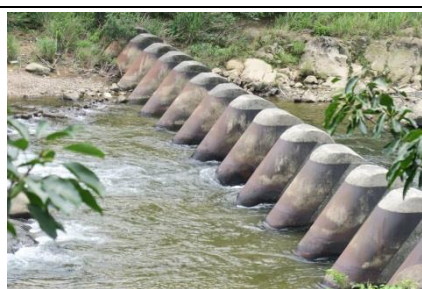
圖 4-2 類型 2 基隆河梳子壩 (本圖由指導老師拍攝)
