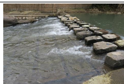
圖 4-3 類型 3 公司田溪梳子壩 (本圖由指導老師拍攝)
