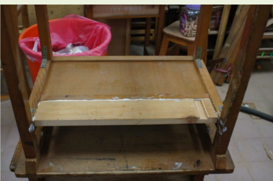
圖5-17 A1補強法前櫃橫桿厚度2cm寬度7cm補強到柱子位置
