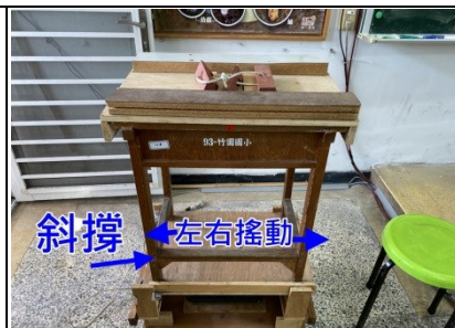
圖 5-13 斜撐補強
