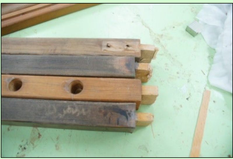
圖5-2 前後向8個接樁接樁粗大，接樁大，長度31cm。長4.0cm、寬1.0cm、深2.5cm。
