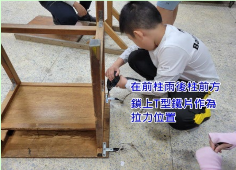
圖3-4 桌面下方前後柱位置裝上T型補強
