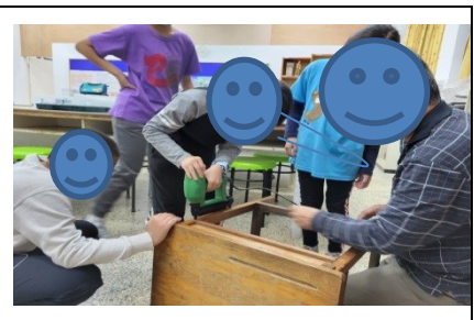
圖 5-18 最後用氣動釘槍 F30 側向加強防止木榫脫離
