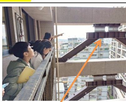
圖圖 4-14 軟鋼阻尼器 (本圖由老師拍攝)
