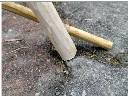
粗糙地面搭設 Y 型支架才不易滑脫(圖 67)
