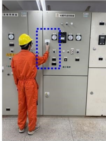
圖 15 利用 YOLO-Pose 通電狀態開啟配電盤門板關節點偵測
