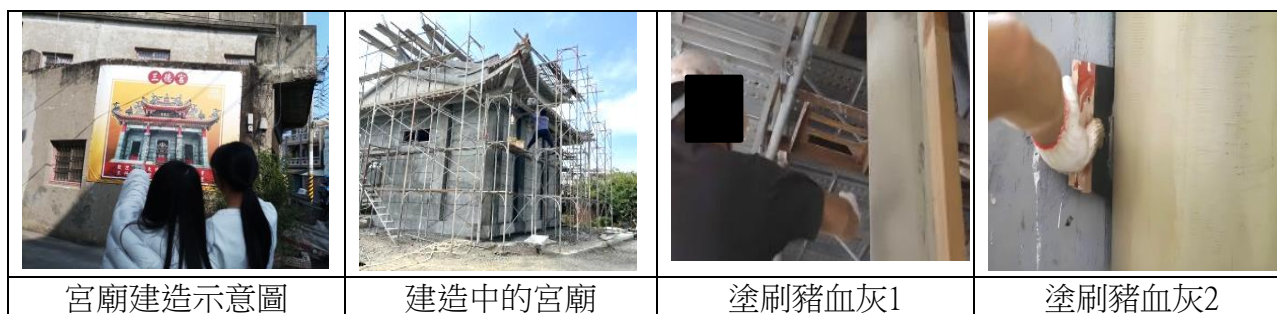
圖30 宮廟建築豬血灰施作圖
