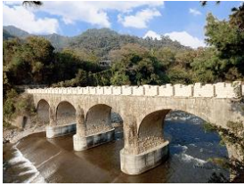
國姓鄉北港糯米橋 本圖引自玩全台灣旅遊網 「南投縣國姓鄉糯米橋」
