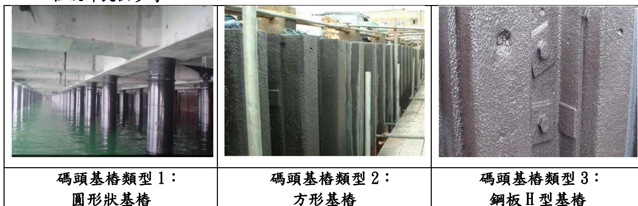
圖 5、各式碼頭基樁主要的形狀(來源: Copyright © 緯固工業有限公司網頁)
