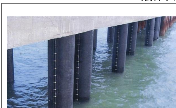
圖 28、當地河岸碼頭圓形的基樁(來源: Copyright © 緯固工業有限公司網頁)
