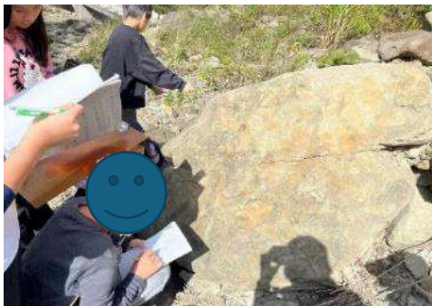
這塊砂岩上有幾處砂棒和砂棒脫落的痕跡與氧化鐵，接近岩石中間處還有一處裂痕，可能被其它岩石推擠過。本照片由作者親自拍攝。
