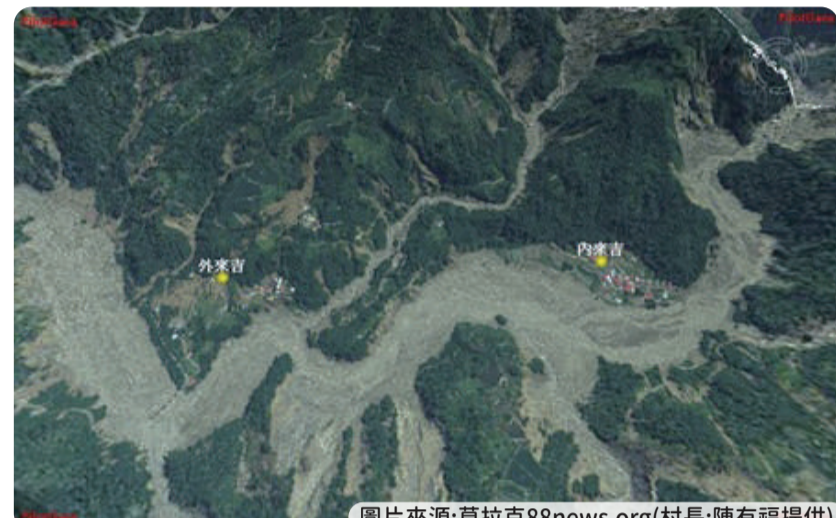
莫拉克颱風後來吉附近的空照照片。當山溝與主河道匯流後，豪大雨帶來的土石佈滿河道，使河床與階地高度接近。
