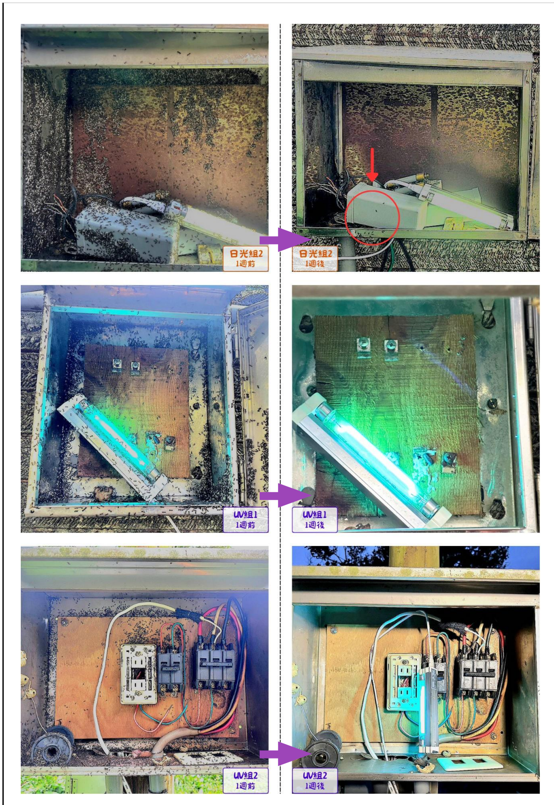
圖十一、驅趕實驗中日光燈和UV燈處理組配電箱一週前和一週後疣胸琉璃蟻數量的變化（作者攝影）
