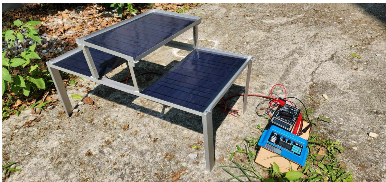
▲圖 32、測試單一太陽能板發電功率和總發電功率
