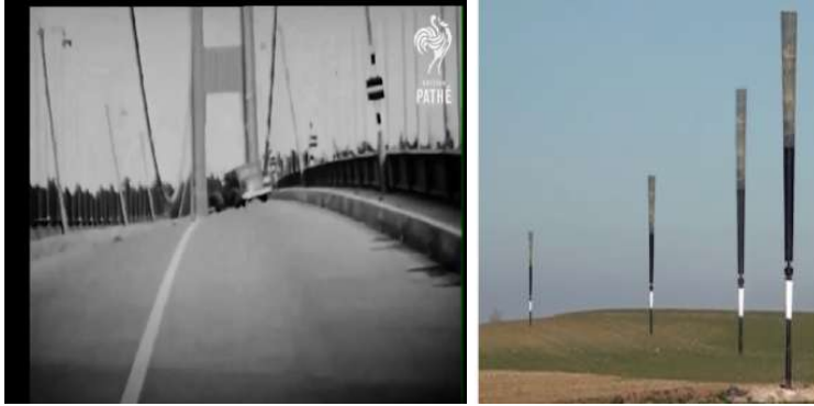
圖1-1-1卡門渦街把一座橋吹斷 圖1-1-2無葉風扇
