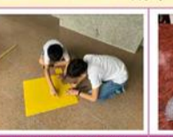
圖5.4 測板放樣情形
