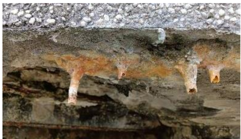
圖 54 橋樑下的管狀物
