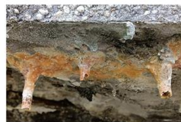
圖31 橋樑下的管狀物
