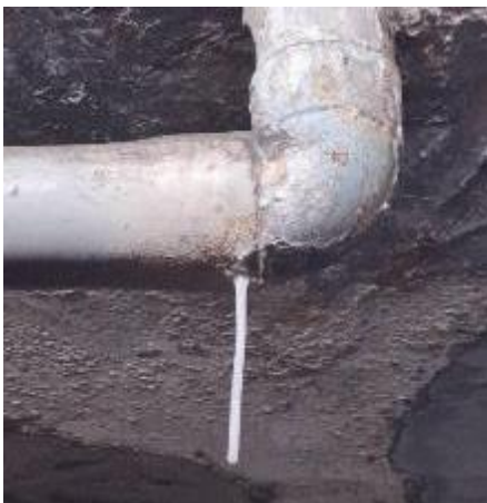
圖 53 停車場天花板的管狀物
