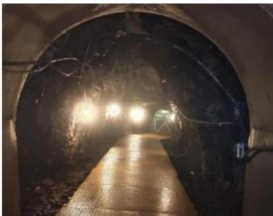
圖 28 德興礦坑入口隧道
