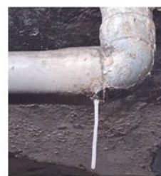
圖30 天花板的管狀物
