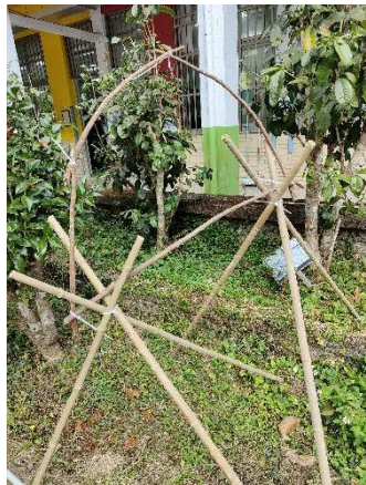
圖十八、用竹子、樹枝和束帶搭一個棚架
