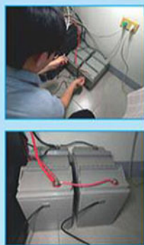
感測器安裝電池旁偵測溫度變化
