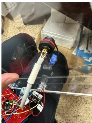
(圖十八)防水盒之防水接頭製作
