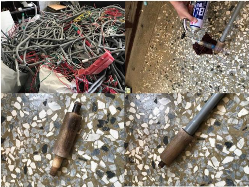
圖11【左上】大量的廢棄電管。【左下】擴管氣【右上】利用瓦斯噴燈加熱軟化【右下】利用擴管器製作電管接頭，用以連接電管
