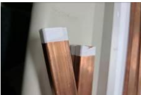
圖九、以防水膠布纏繞銅管
