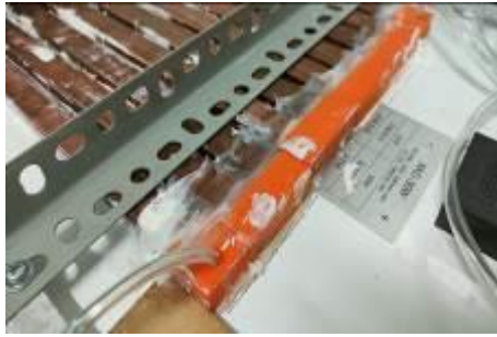
圖十一、銅管塞入轉接結構(膠布+填縫劑密封阻水)
