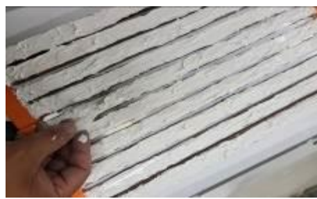
圖十五、導熱膏塗抹狀況
