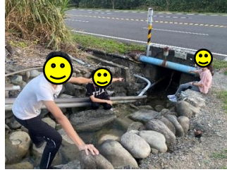
圖二、橫跨台26線公路之涵道
