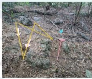
測量裂縫方位
