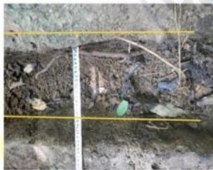
測量裂縫寬度
