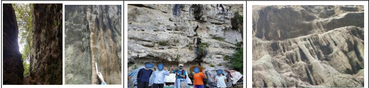
圖3-19 :在碧水洞廟宇後方一線天岩壁上，有許多大裂隙，岩壁上散佈鐘乳石和水流過的碳酸鈣沉積。
