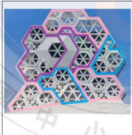
利用幾何拼板 將整個牆面做切割分塊
