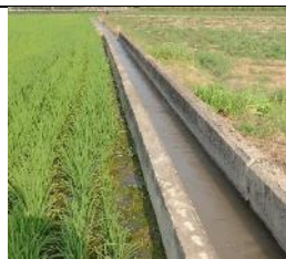
圖 6-30 溝渠水泥化
