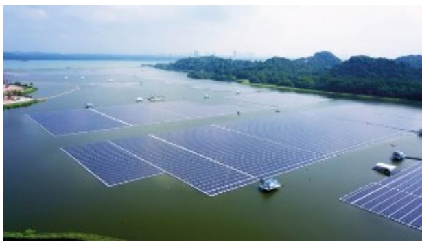
圖 1-1、勝科登格浮動式太陽能電場 (Sembcorp Tengoh Floating Solar Farm) 位於新加坡西部集水區的登格蓄水池 (Tengoh Reservoir)，總容量高達 60MW (Daisy Chuang, 2021)
