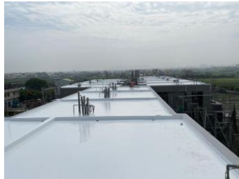
圖 47：建築物屋頂塗白漆
