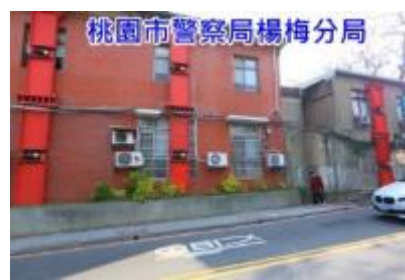
水平式油壓阻尼器
