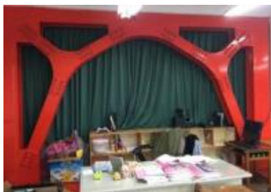
本校框架結構補強
