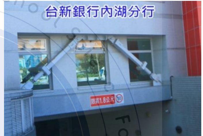
斜撐式油壓阻尼器
