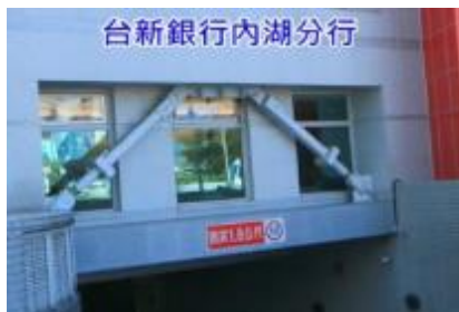
斜撐式油壓阻尼器
