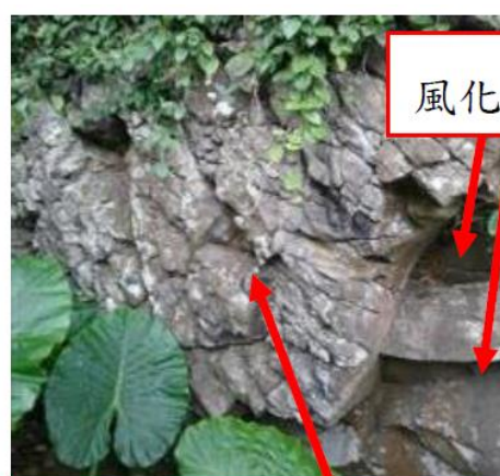
特殊明顯的崩裂風化節理
