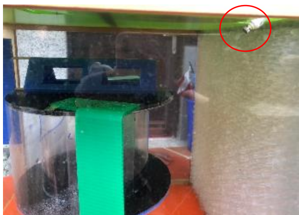
圖 4-12-4 造霧機安裝在進氣開口前上方
