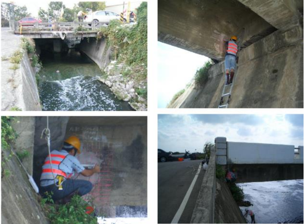
圖 7：人員進行橋樑檢測
