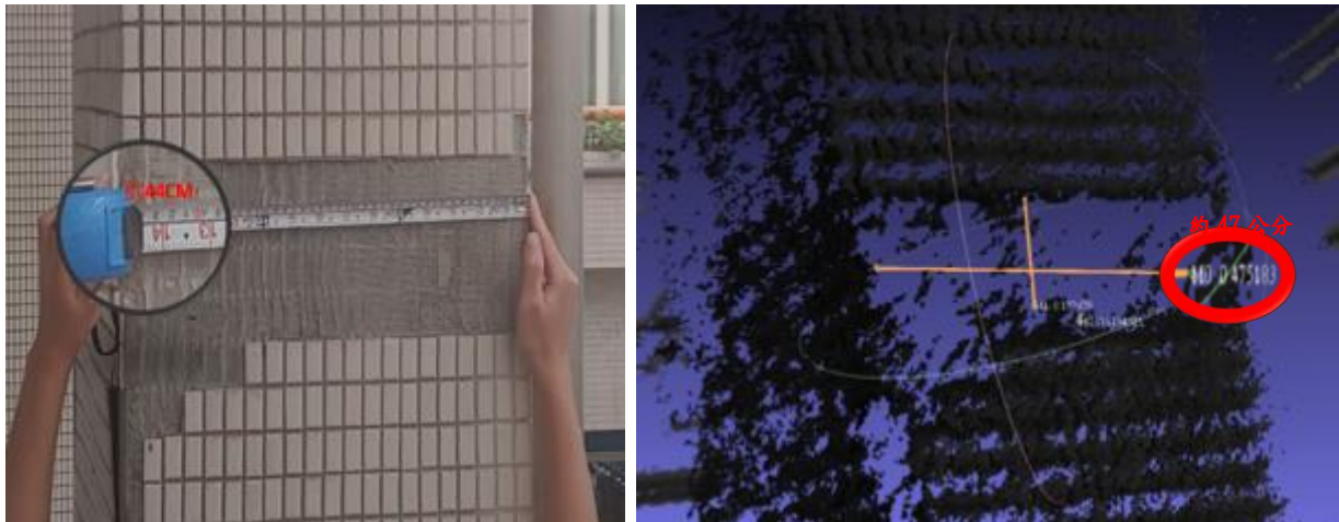
圖 18：建模計算劣化面積
