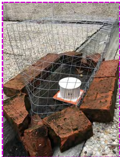
圖 6.15 增加自製落水頭加速排水
