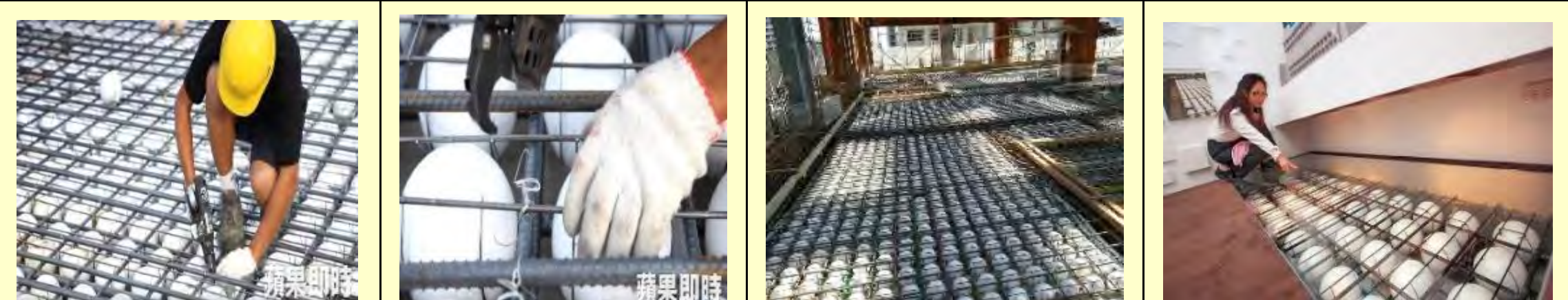
將保麗龍球放在輕隔間內，灌入水泥，讓房屋的耐熱、耐震性能較好。
