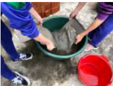
圖 4-54 將普通水泥倒入砂盆中
