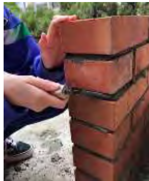
圖 4-45 將其磚牆勾縫完整
