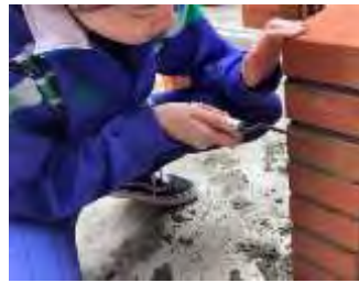
圖 4-51 將其磚牆勾縫完整
