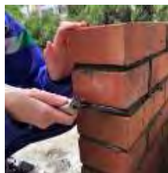
圖 4-58 將其磚牆勾縫完整
