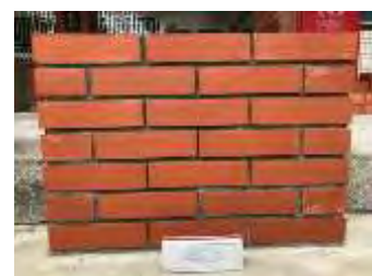
圖 4-59 黑糖水水泥砂漿牆之完成品
