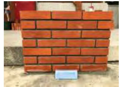
圖 4-46 純水泥砂漿牆之完成品
