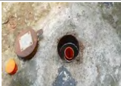
圖 32.湖口地下觀測井全貌
