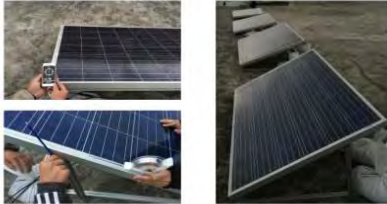
圖 4-8 實際架設太陽能發電系統
